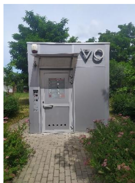
Zdjęcie nr 5. Toaleta publiczna w Mroczy przy ul. Nakielskiej, Park Jagiełły
