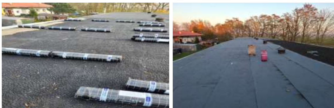
Zdjęcie nr 1-2. Remontowany dach na budynku magazynowym przy ul. Dworzec 1
