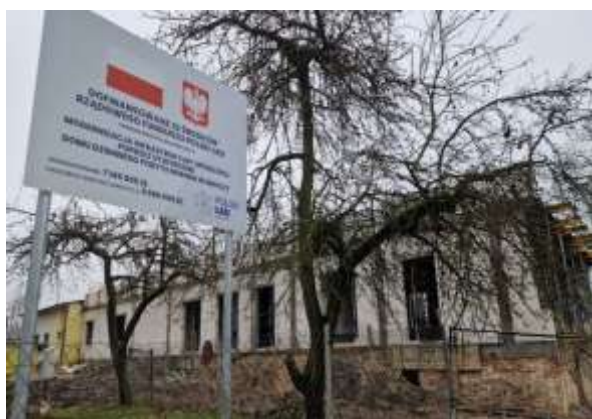
Budynek przy ul. Łąkowej 5 – przed realizacją inwestycji
